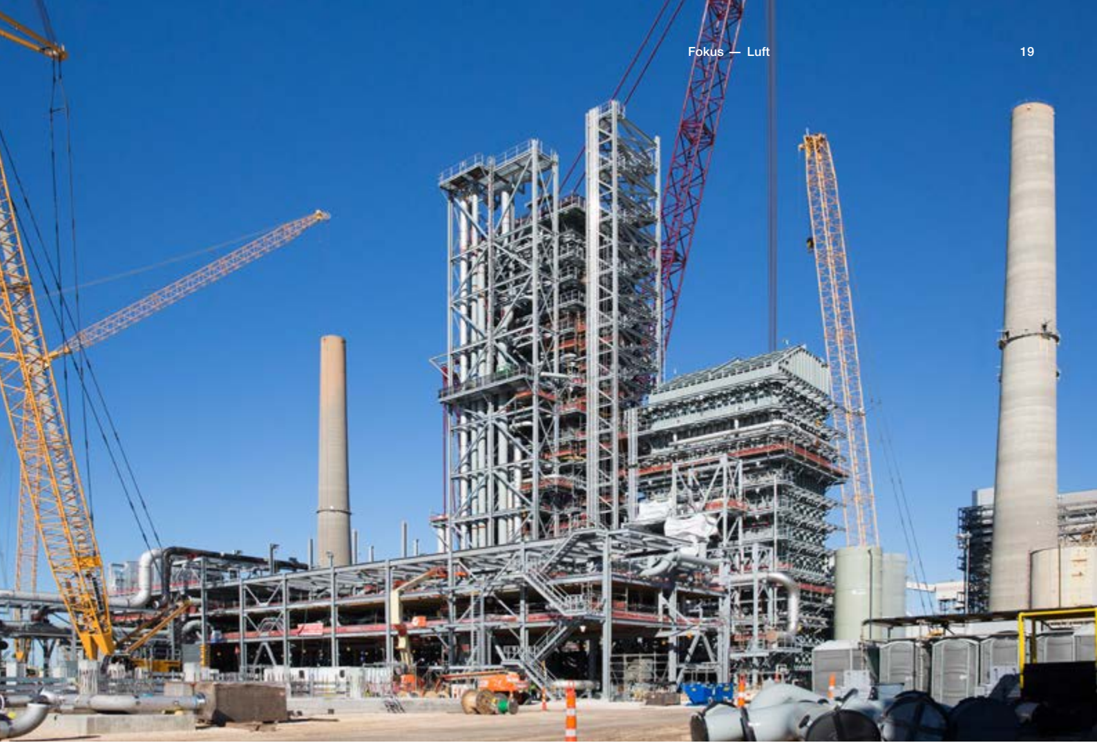
Die Demonstrationseinheit für die Kohlenstoffabscheidung und -speicherung im Parish-Kohlekraftwerk in Thompsons, TX, USA, befindet sich derzeit im Bau. Die Inbetriebnahme wird für dieses Jahr erwartet.
